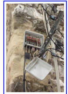
En France, la plupart des câbles sont organisés par regroupement de 7 paires de fils de cuivre, cette structure permet d'optimiser le diamètre des câbles. En fonction de la capacité d'abonnées recherchée, les câbles reproduisent ce type de regroupement par multiples de 7.
