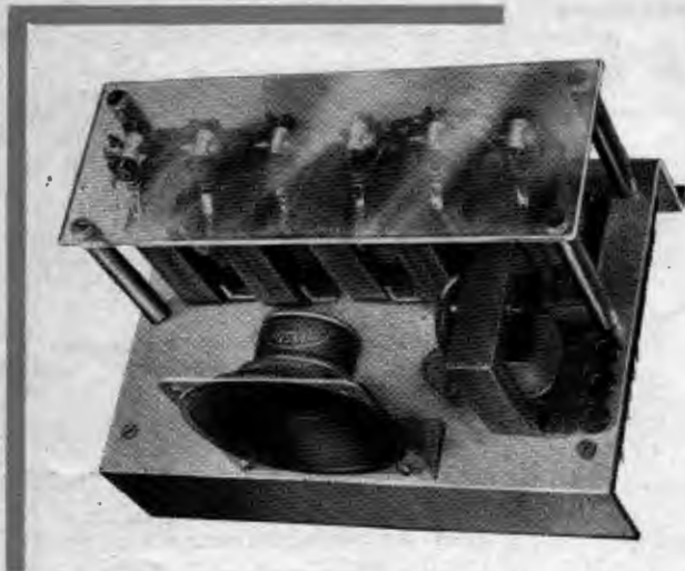
Récepteur de radio, sans aucune lampe, et employant six transistors !
